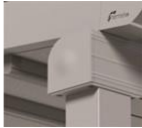
Regnvann ledes ned
